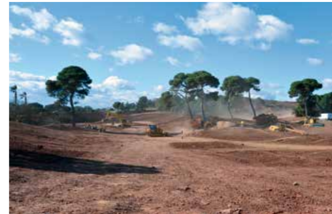
Extension du Golf du Cap d'Agde (34) Architecte : © Alain Prat
