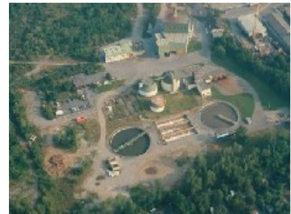
Station d'épuration des eaux usées ©INRA/J.Bertin réf : PCD0004-IMG0007.PCD
