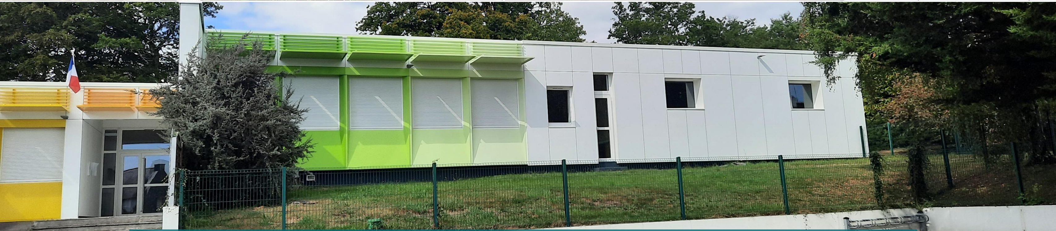
Rénovation énergétique des écoles publiques - CAUDAN
