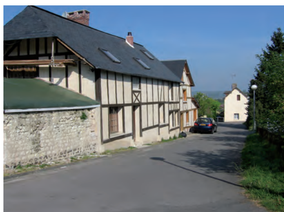
L'absence de trottoir pose la question du cheminement accessible et sécurisé des personnes à mobilité réduite Source : CETE Normandie Centre
